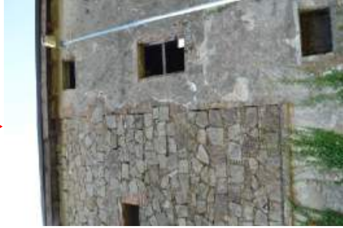
TRACCE SULLA MURATURA ESTERNA, DELL'AMMORSATURA TRA EDIFICIO ORIGINARIO E AMPLIAMENTO DEL XX SEC. VERSO EST
