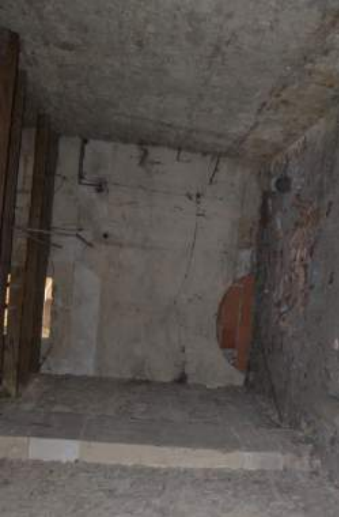
DETTAGLIO INTERNO DELLA BARCHESSA C IN CUI SI VEDONO LE FINESTRE DEL P 1° E LE ARCADE DEL PT TAMPONATE IN SEGUITO ALLA SOPRAELEVAZIONE DEL CORPO A SUD-EST
