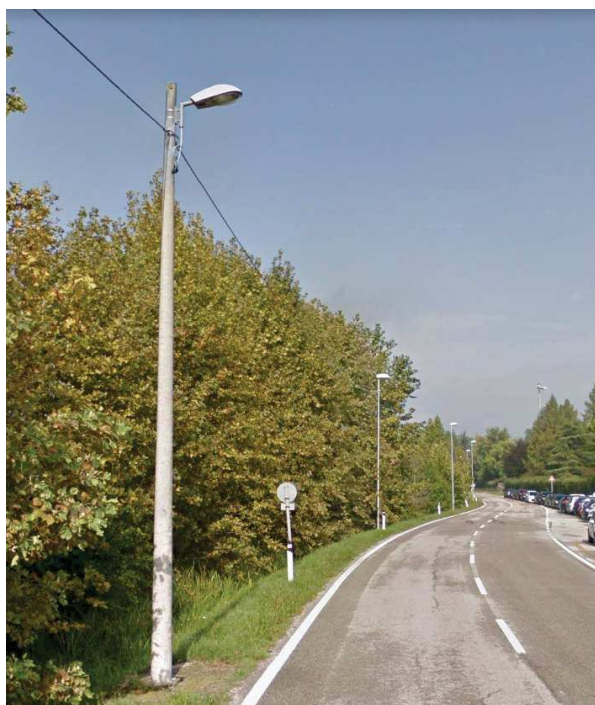
Palo in cemento con apparecchi di illuminazione pubblica
