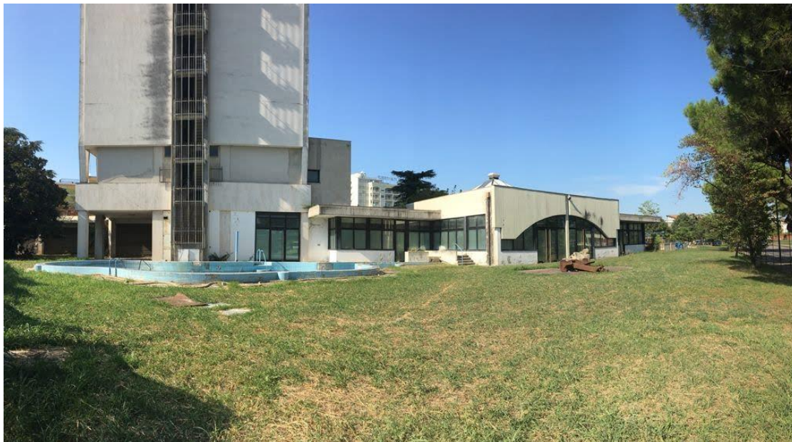
Fronte sud da Via Amerigo Vespucci
