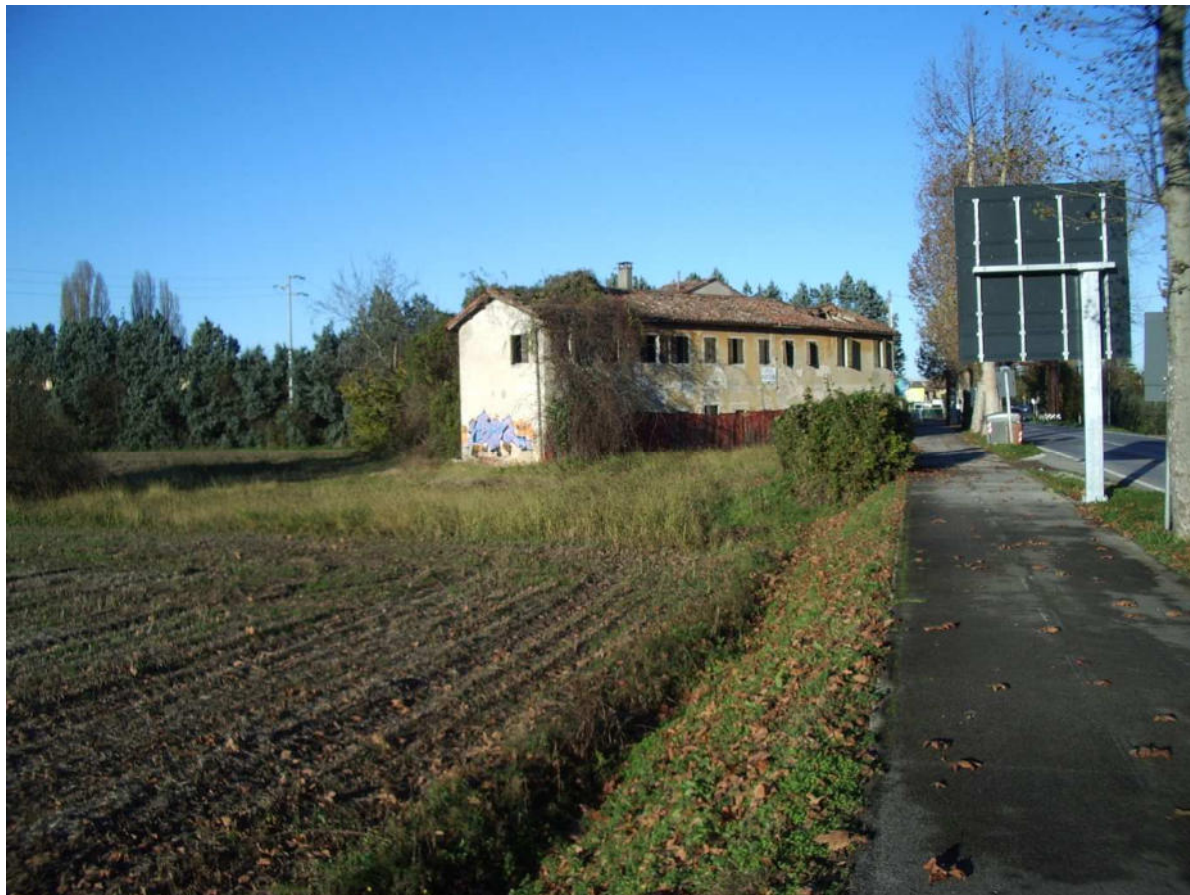
Foto n. 11: Edifici sull'area soggetta a PP9 da demolire
