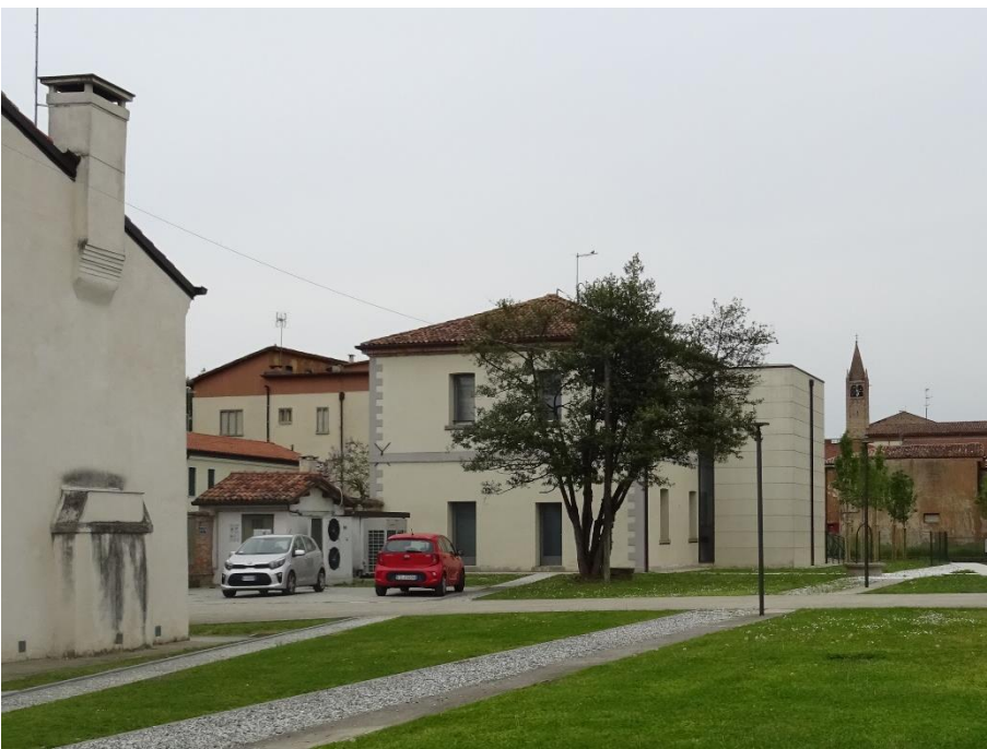
Foto n. 51 – Edifici n. 32 e 33
