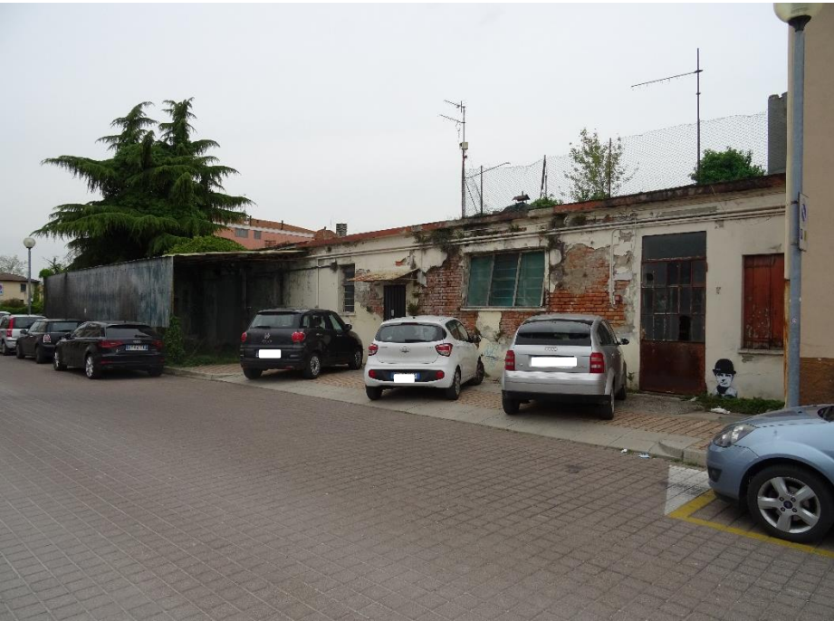
Foto n. 46 – Edificio n. 66.a
