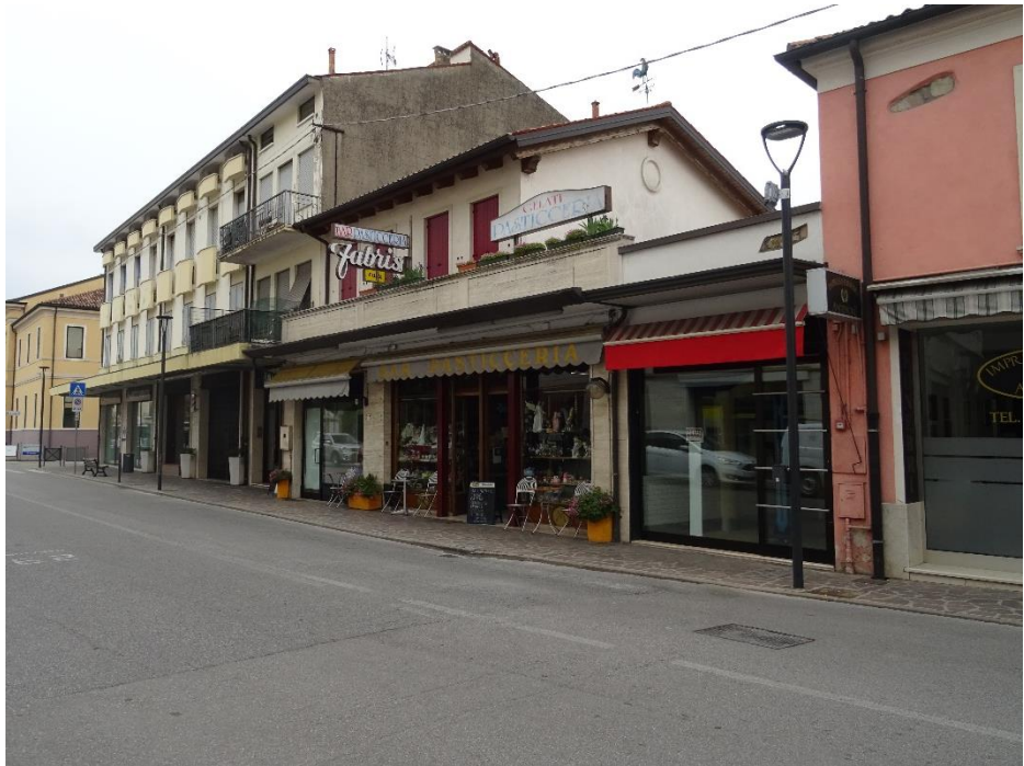
Foto n. 3 - Edificio n. 27.b
