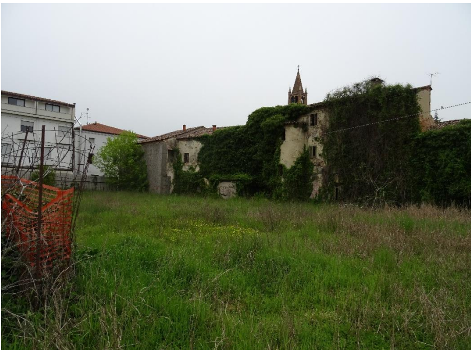
Foto n. 65 – Lotto n. 12 sud
