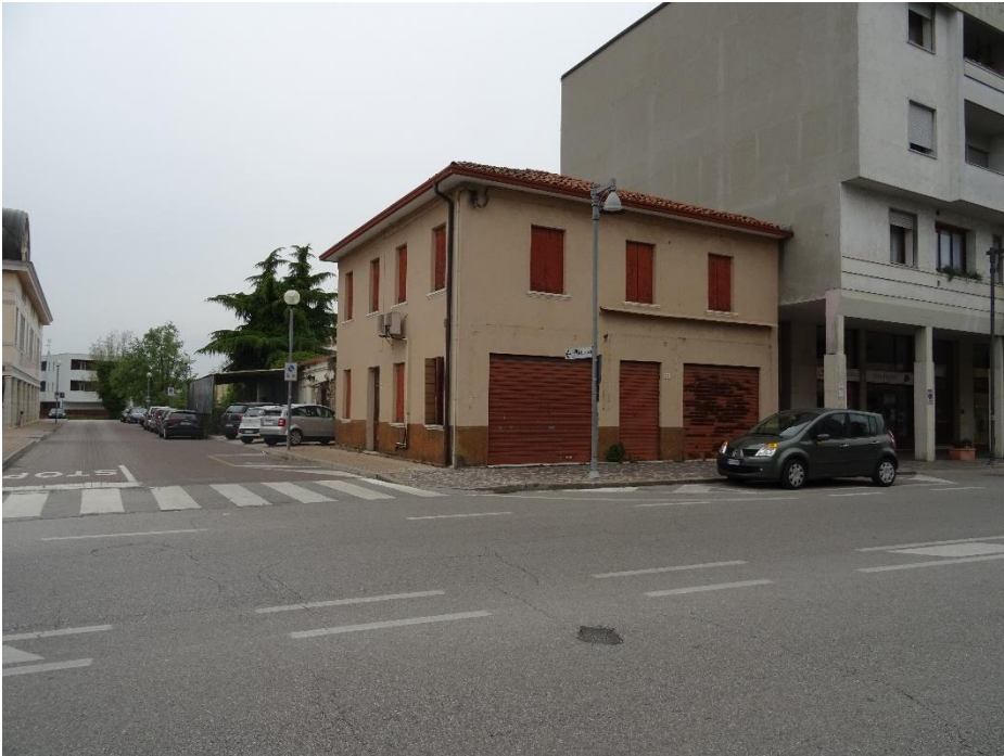
Foto n. 29 - Edificio n. 66.b
