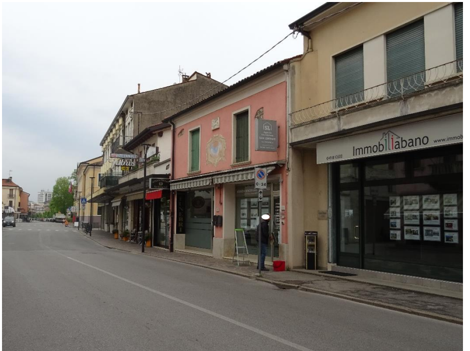
Foto n. 4 - Edificio n. 27.a
