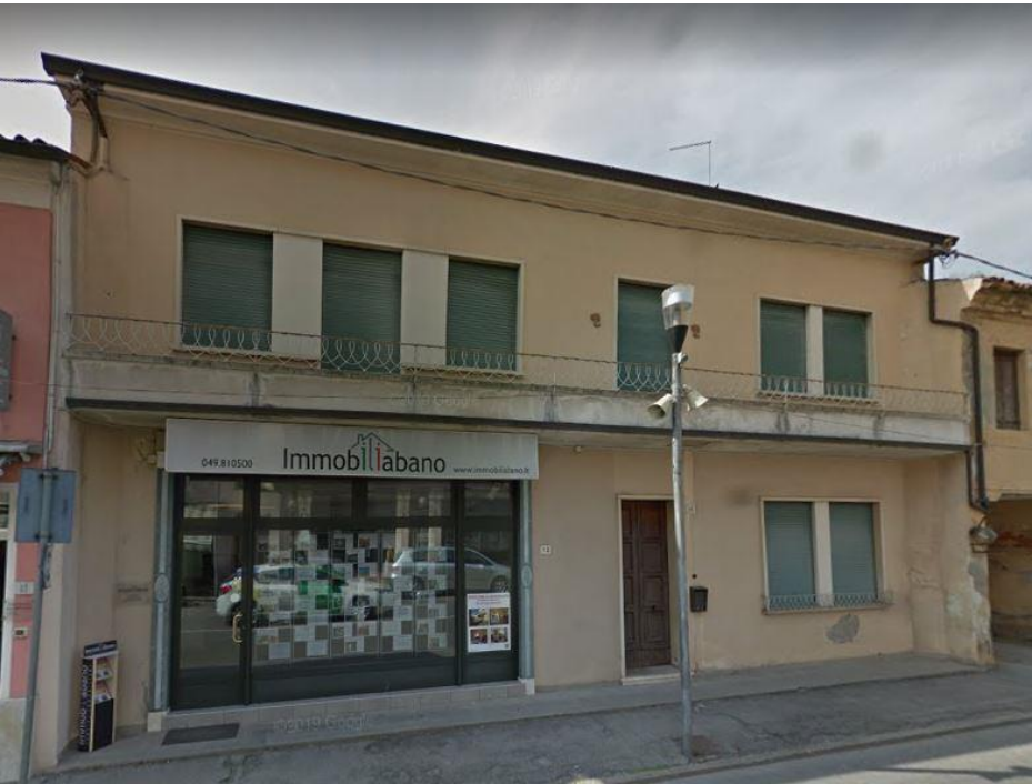
Foto n. 5 – Edificio n. 27.c
